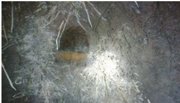
Bild links: Schadensbild (Risse, Durchwurzeln) in einem Abwasserkanal
